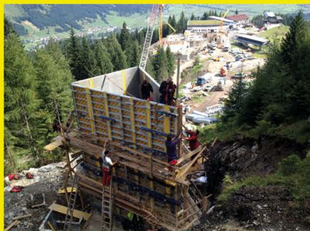
Streckenfundamente + Kabelgraben
